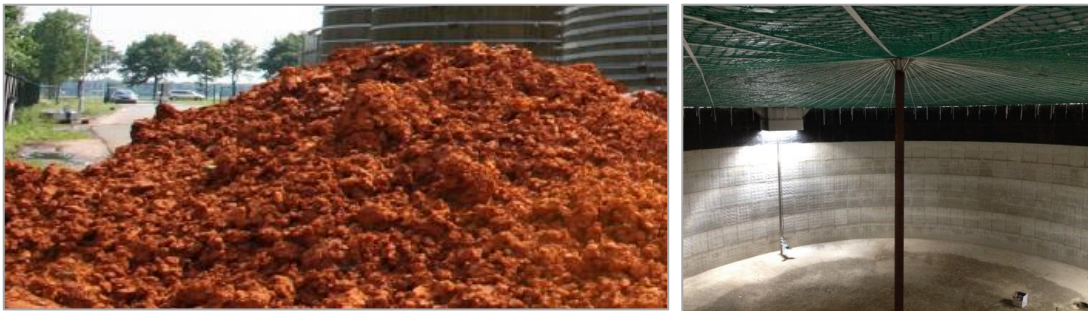
Photographie 14 : Hydroxyde de fer solide (à gauche) et filet pour la désulfuration biologique (à droite) (Source : Biogas Plus)
