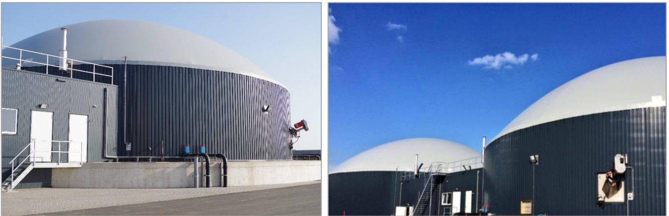
Photographie 13 : Exemples de digesteur et bâtiment technique accolé (Source : Biogas Plus)
