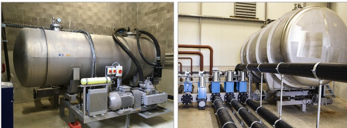
Photographie 12 : Exemples de système de pompe à vide (Source : Biogas Plus)
